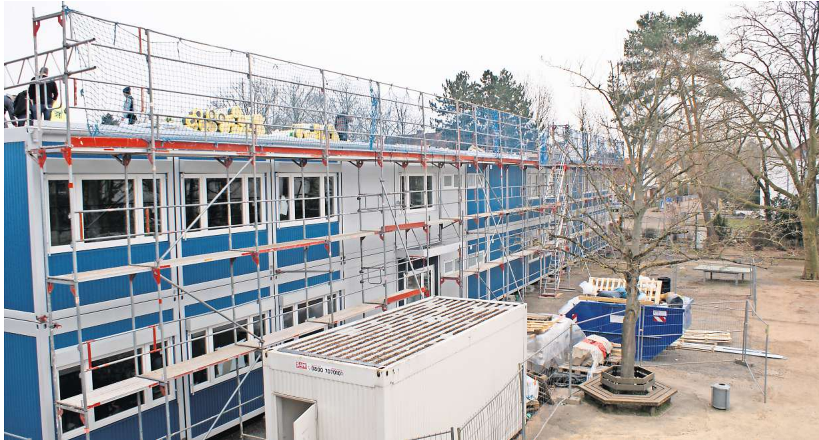
Das neue Modulgebäude besteht aus insgesamt 79 Containern und bietet Platz für bis zu zwölf Klassen.
